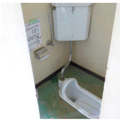
▲美谷本小学校のクラブハウストイレ
